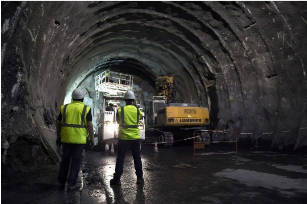
Des ouvriers travaillent sur le chantier du tunnel du Mont-d'Ambin. (PHILIPPE DESMAZES AFP)
